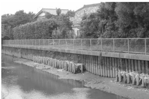
鍋木川護岸状況（大型土のう等による応急措置）
