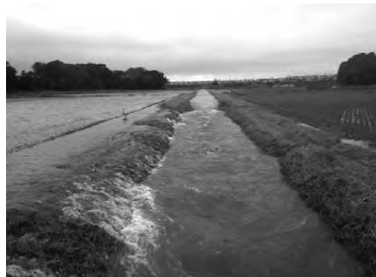
【平成25年 湛水状況】
