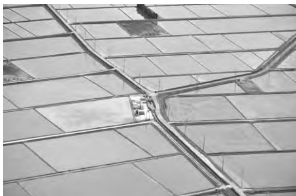
▲東部幹線水路東金東分水工 (開水路は支線水路。三方向に流れる) 「幹線水路は写真左から右に流れ、農道下に埋設」
