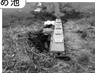
斜樋部に陥没
