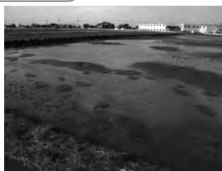
液状化による噴砂工
