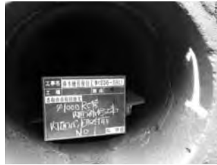
排水樋管の破損
