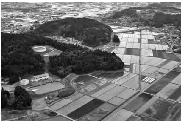
▲新第3揚水機場(奥に公平水路橋)
