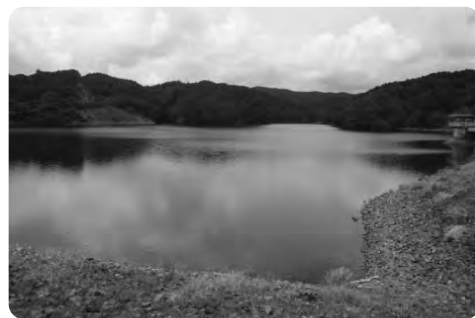
勝浦ダム貯水状況
