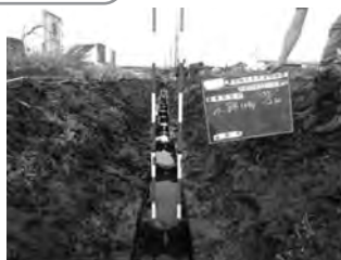
破損した柵渠
