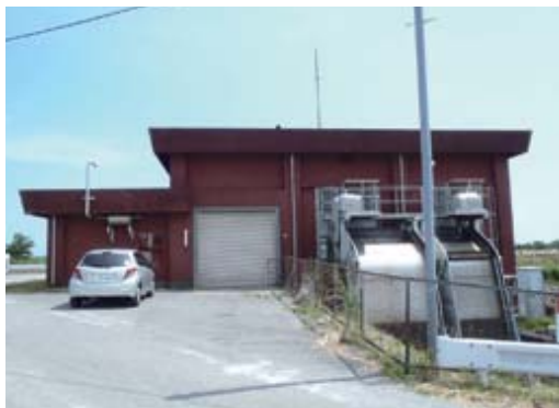
▲南白亀第一排水機場
