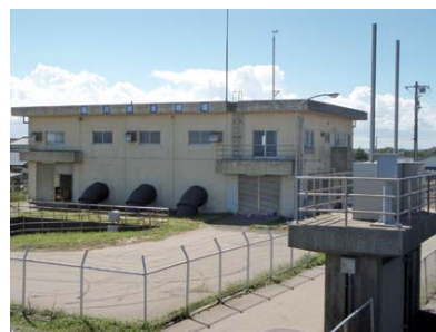
▲堀川排水機場
