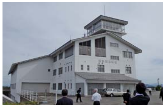
▲南部排水機場の様子
