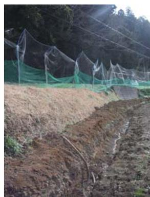
▲湧水対策のため大きく掘られた明渠排水路と簡易サル侵入防止柵
